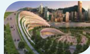
West Kowloon Terminus (WKT), Hong Kong 香港西九龙总站
